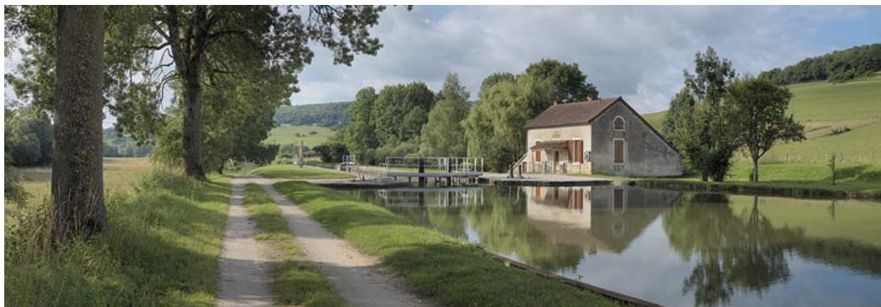
Site d'écluse vu d'amont.
