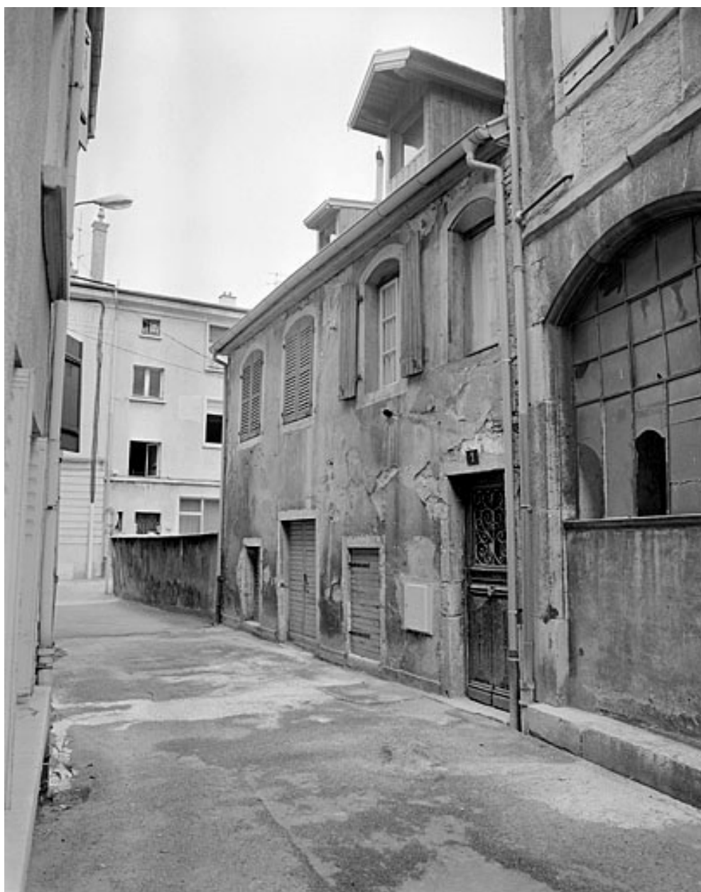
Façade sur la rue des Tanneries.
