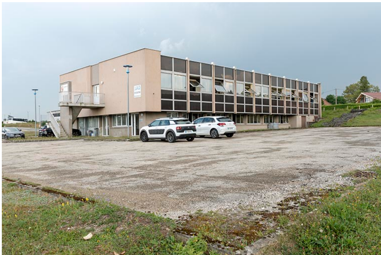
Façades postérieure et latérale droite.
