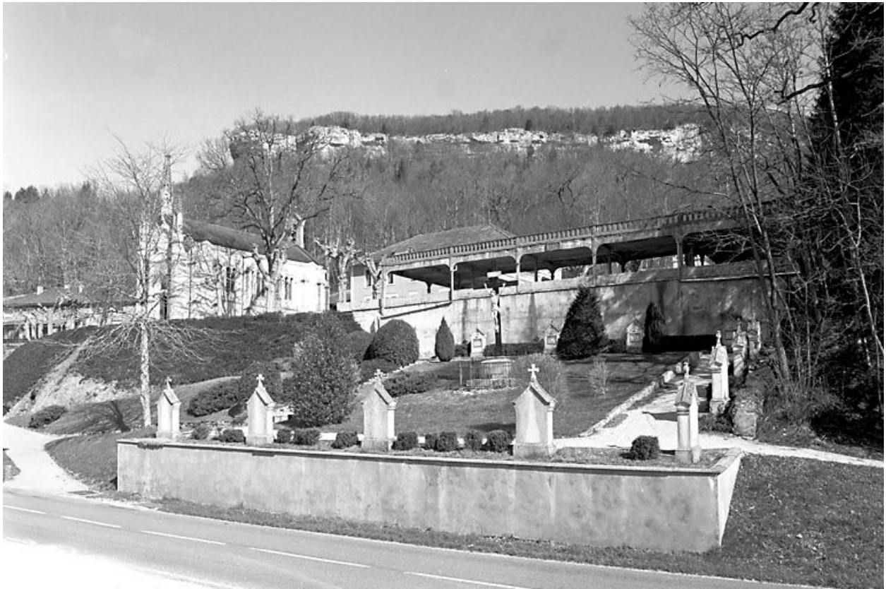
Vue d'ensemble depuis la D 101.
