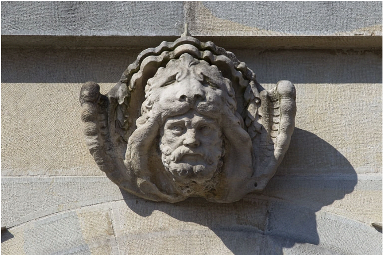
Portail dans clôture, détail de la clé de l'arc : tête d'hercule, vue rapprochée.
