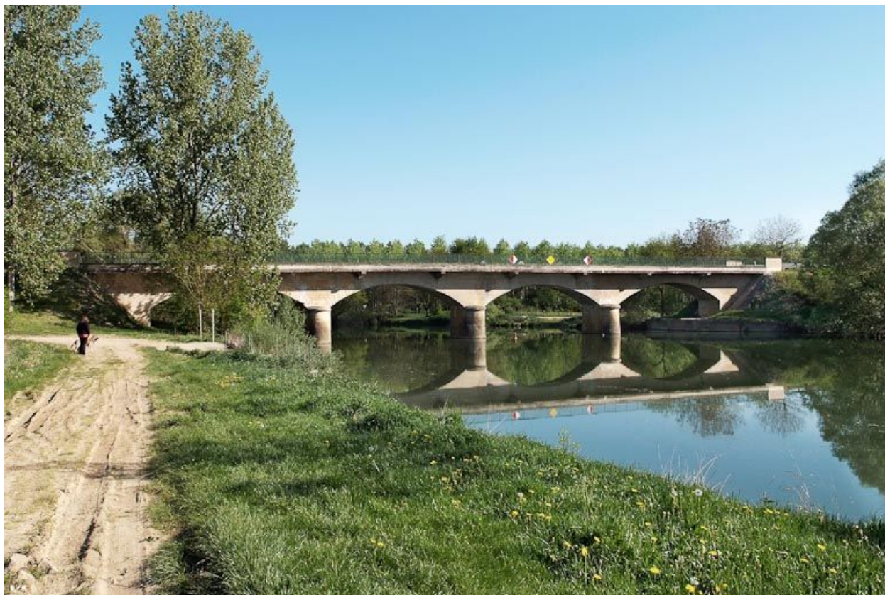
Pont vu d'amont.
