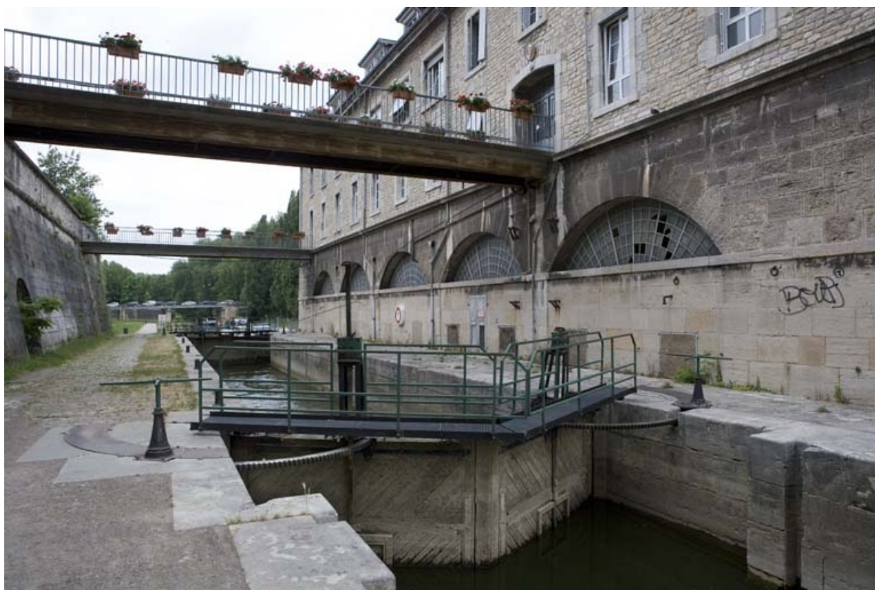
Vue d'ensemble depuis l'amont, côté gauche.
