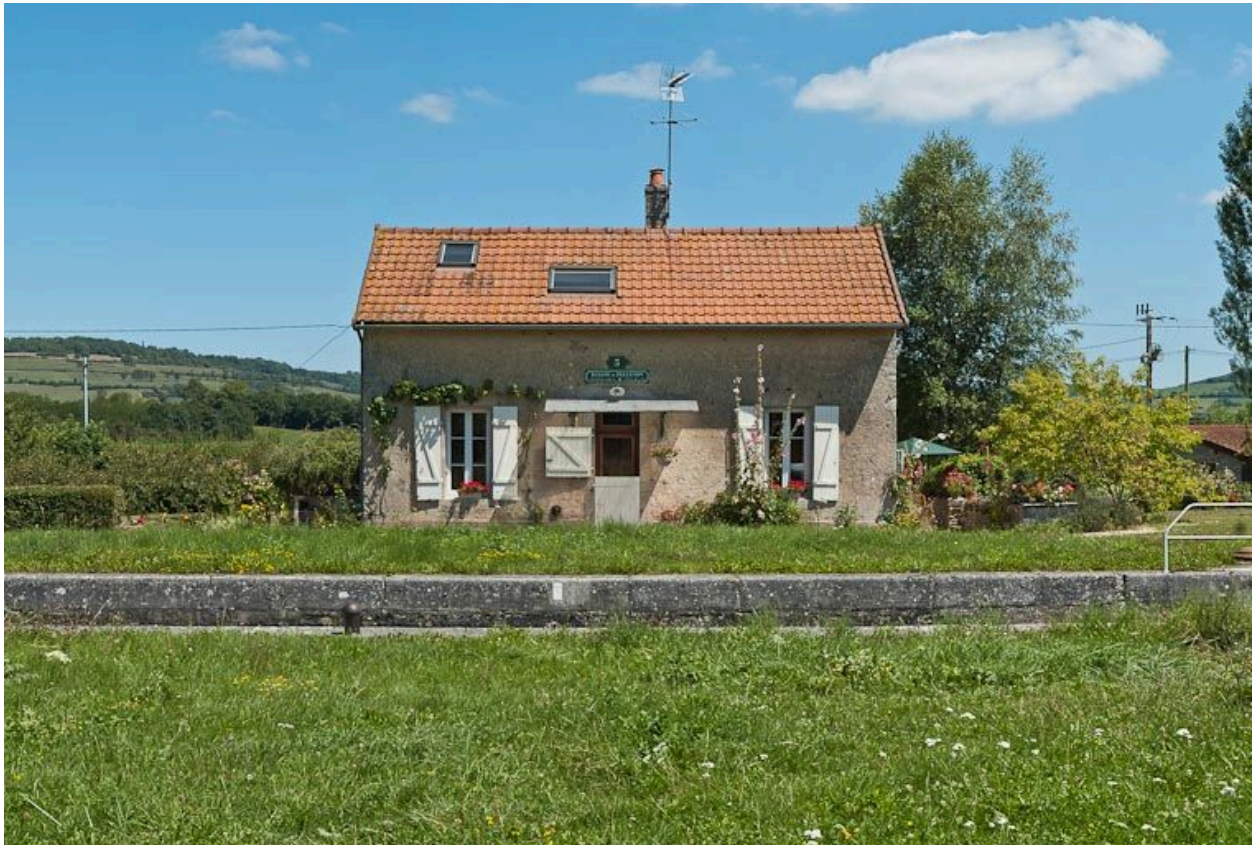
Vue de face de la maison éclusière.
