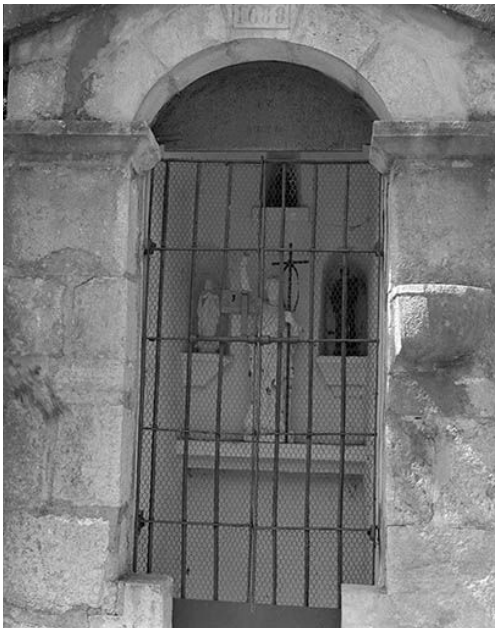
Porte d'accès à l'autel, grille.
