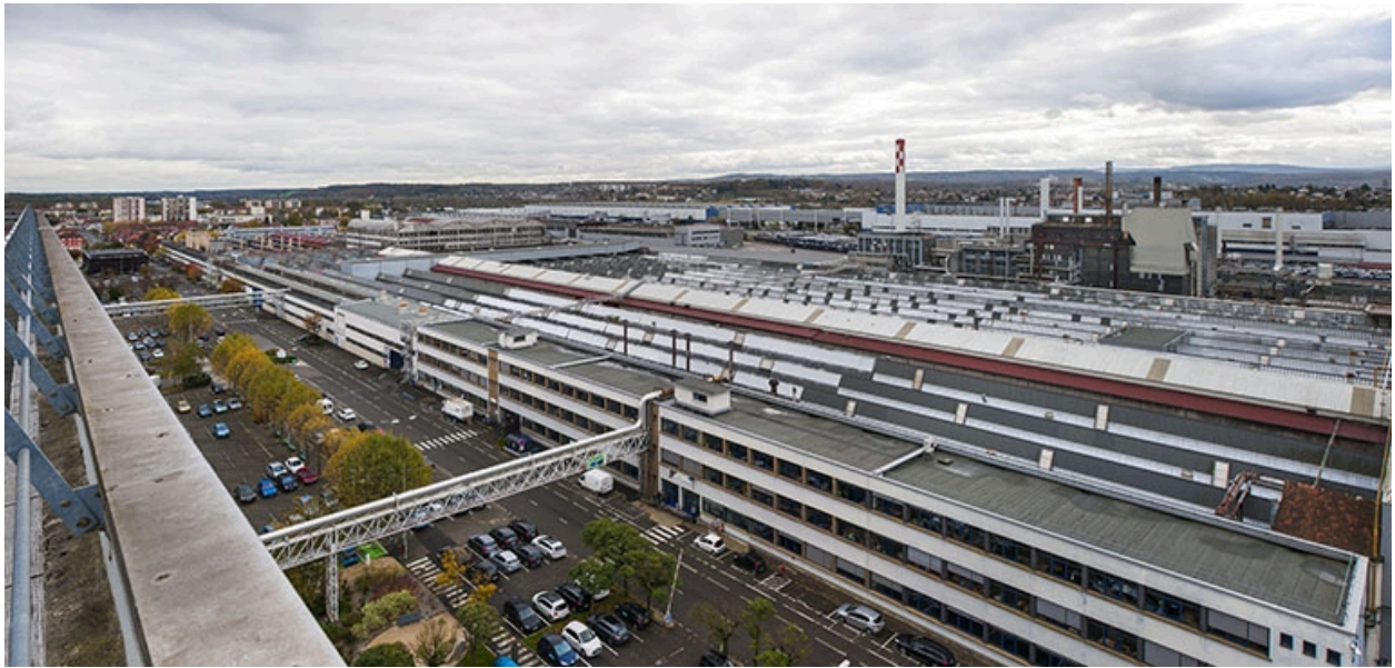
Vue d'ensemble de l'atelier de ferrage.
