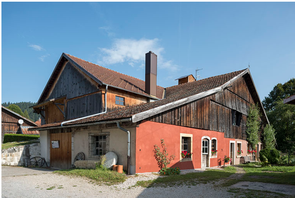
Façades antérieure et latérale gauche.
