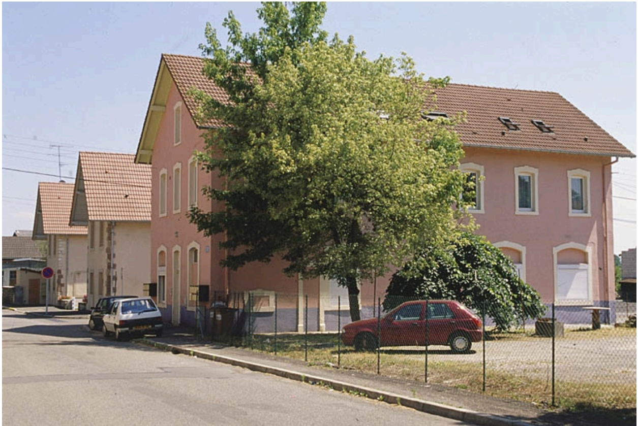
Logements ouvriers depuis l'avenue des Forges.
