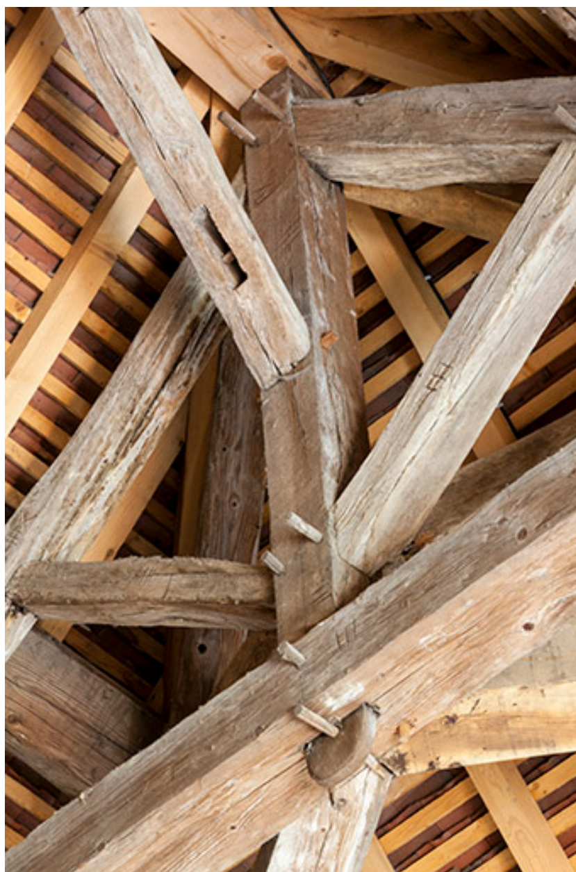
Assemblage de la ferme de la croupe. Détail.
