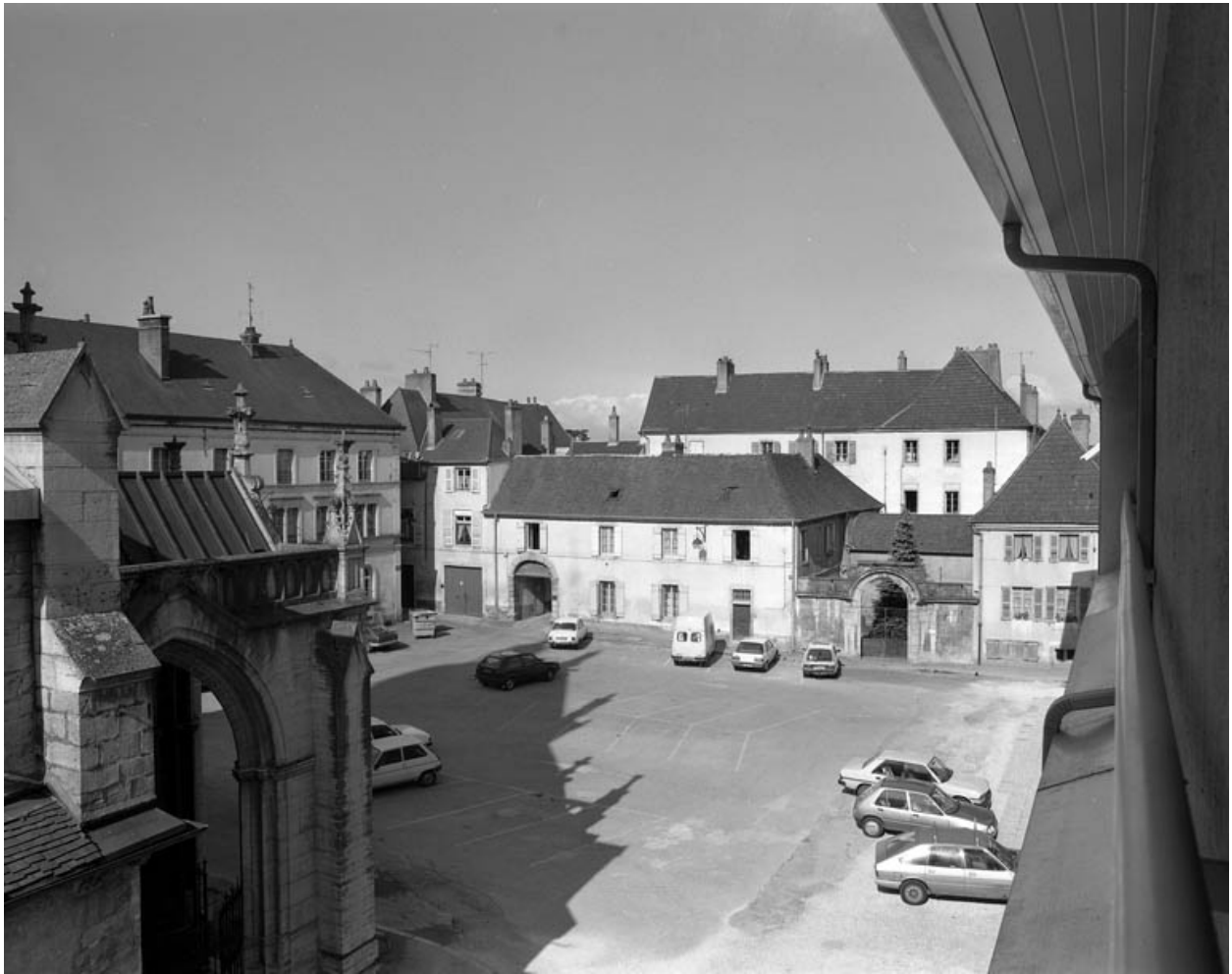
Façade antérieure sur rue : vue d'ensemble.
