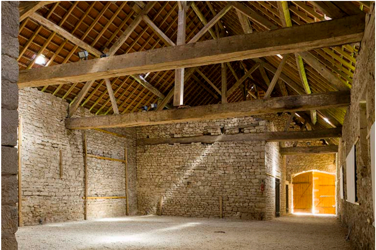
Intérieur du cuvage, en direction du sud-est.
