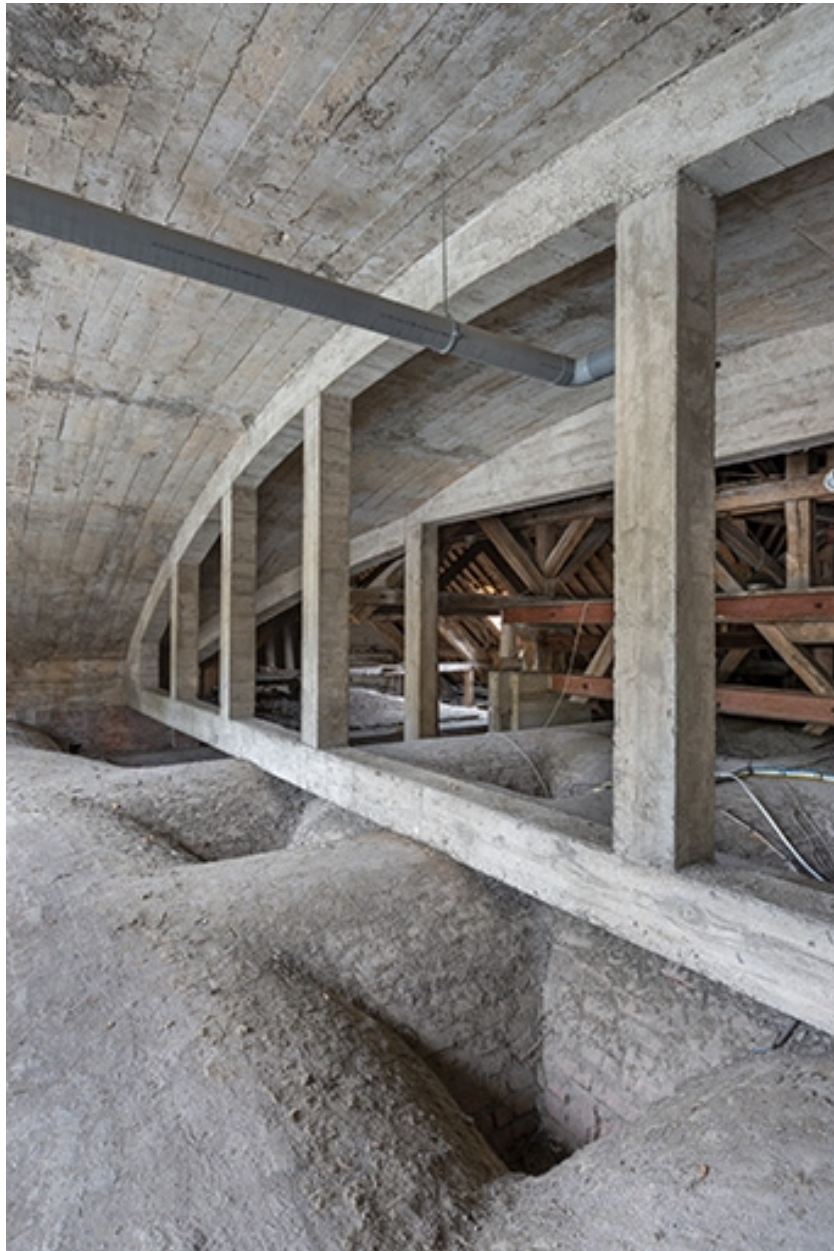
Fronton de la façade nord, vue intérieure.
