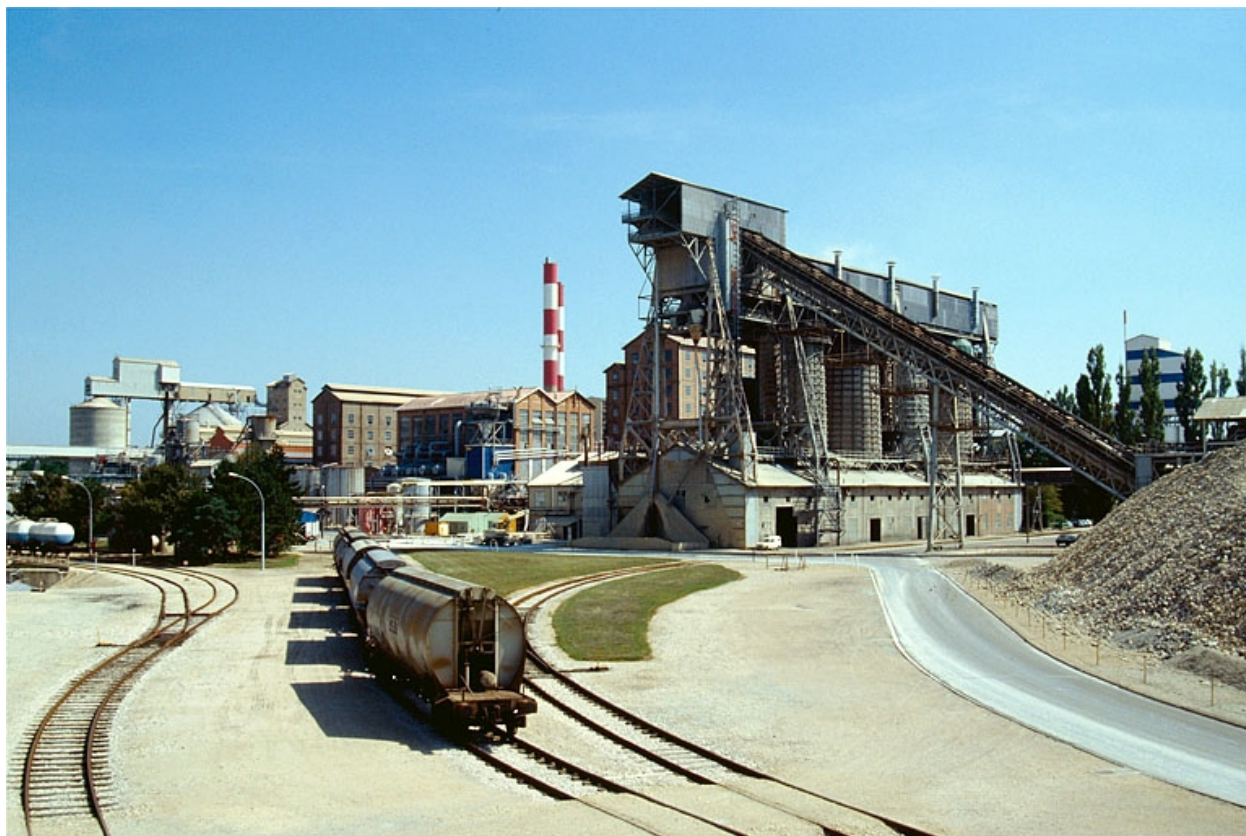
Caisses à soude, soudière et fours à chaux vus du nord-ouest.
