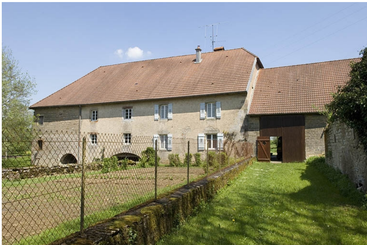
Façade postérieure du moulin.
