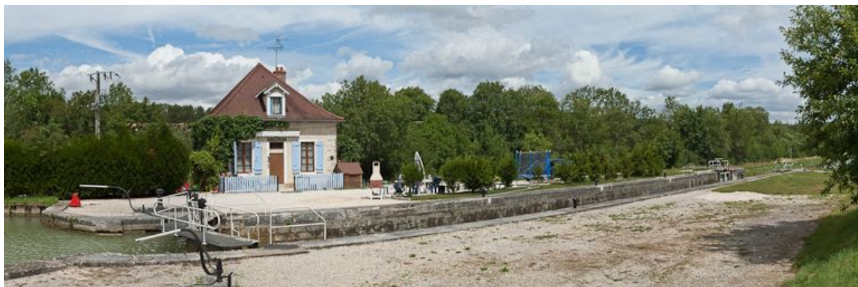
Vue d'ensemble du site d'écluse.
