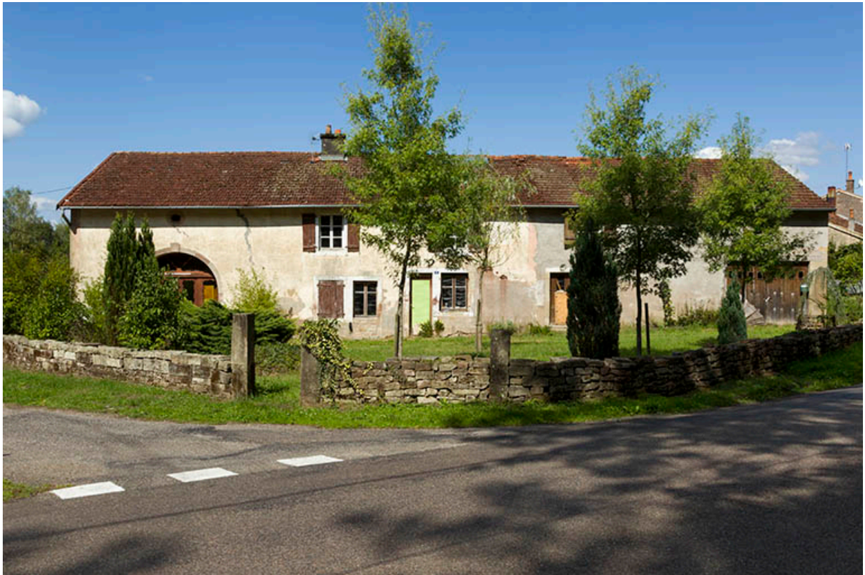
Ancienne épicerie le long de la route départementale.
