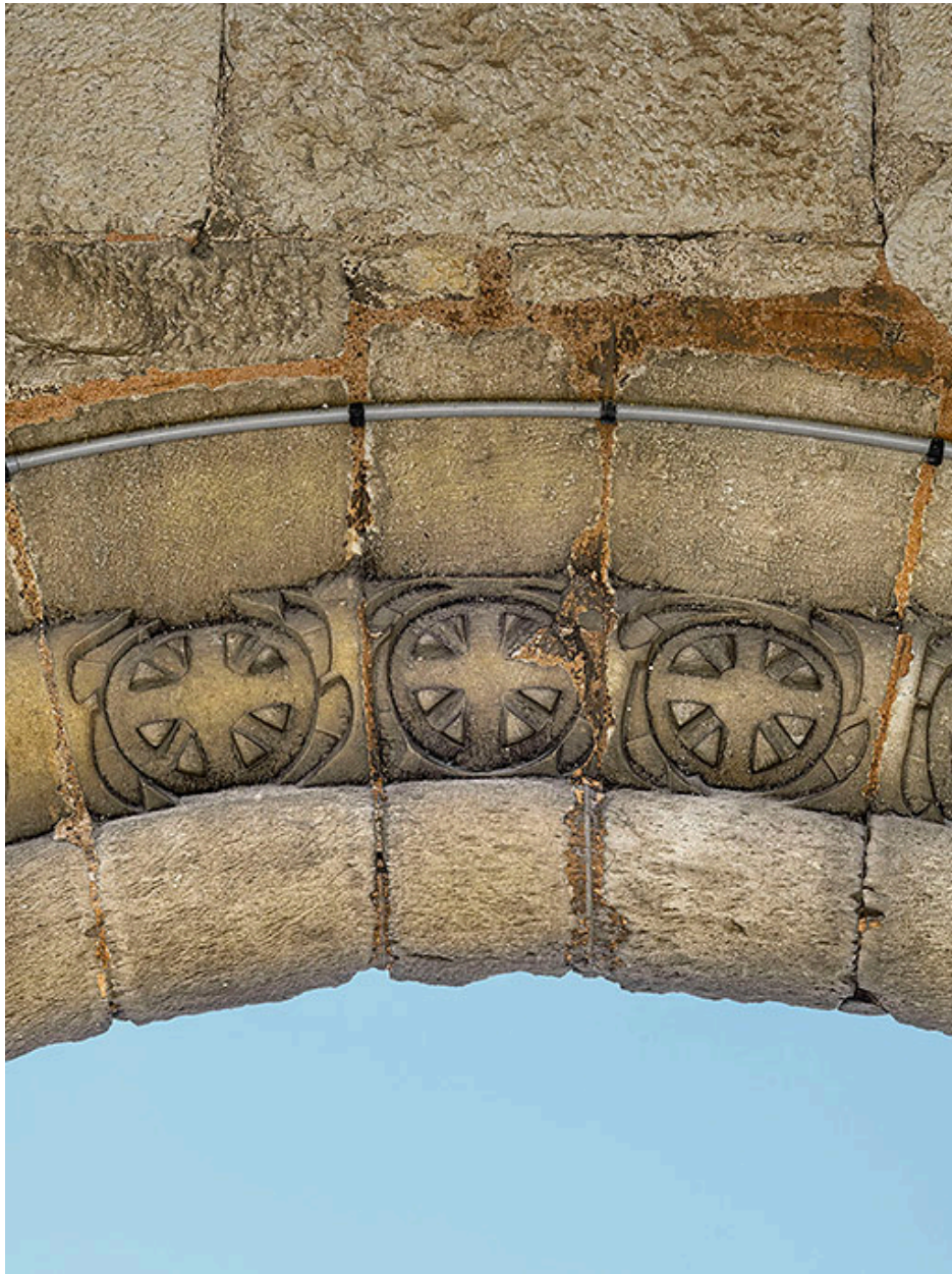
Rouelles sculptées, voûte du passage.
