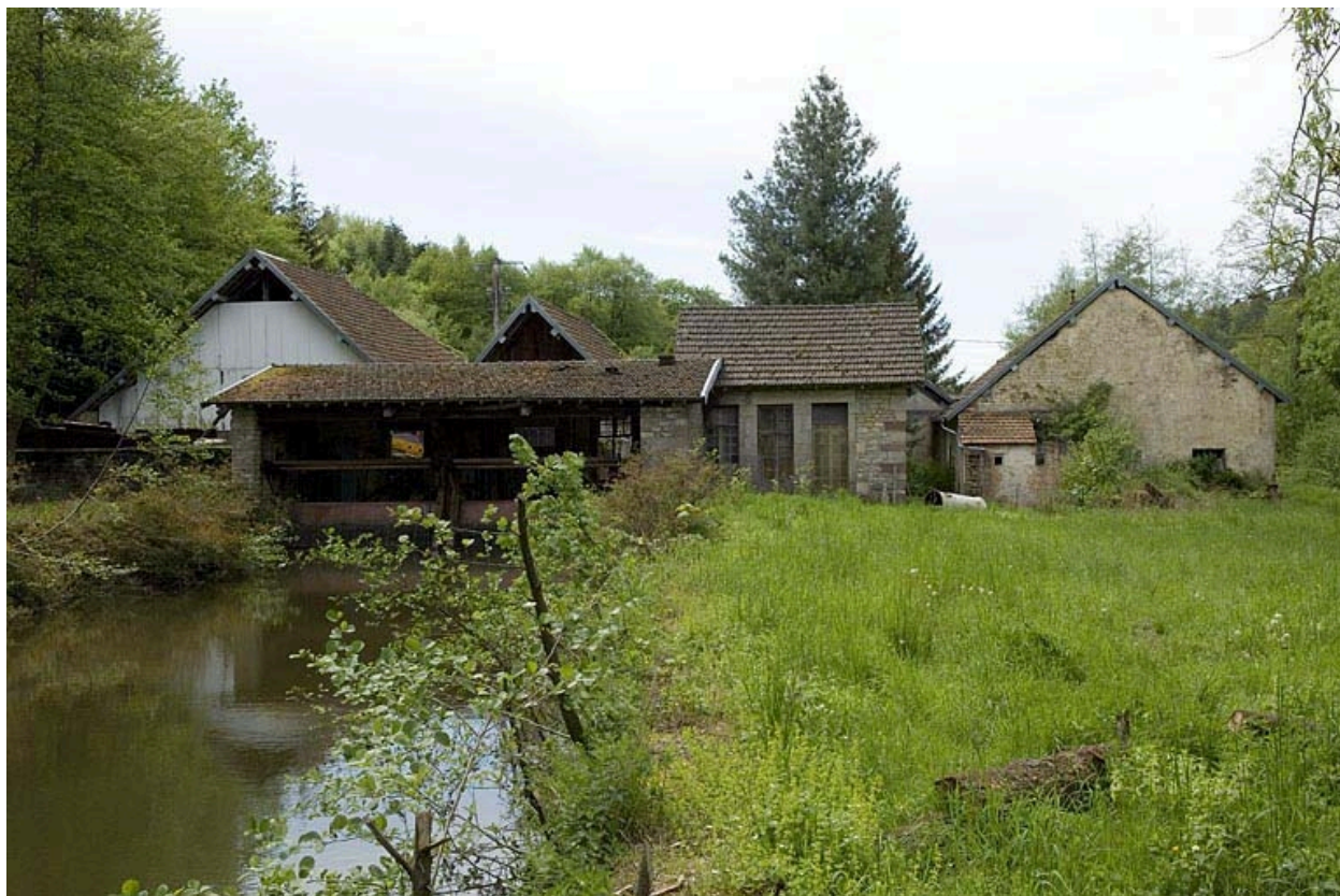
Façades postérieures depuis le bief d'amenée.
