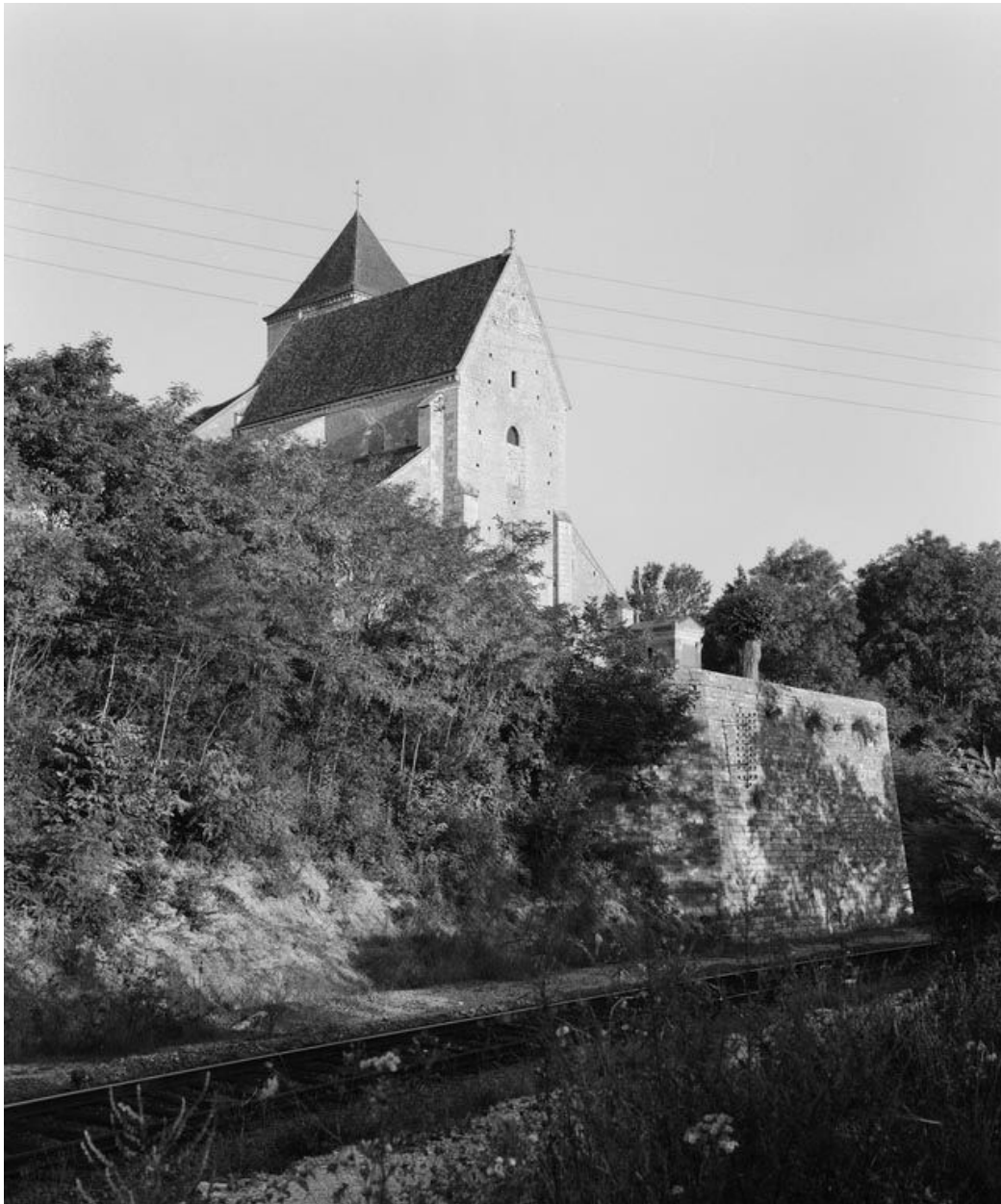
Vue d'ensemble, prise du canal.
