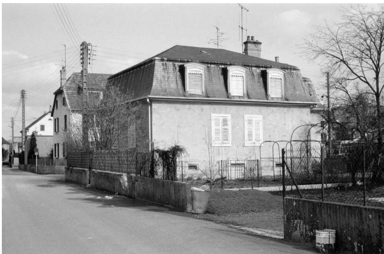
Façades postérieure et latérale droite.
