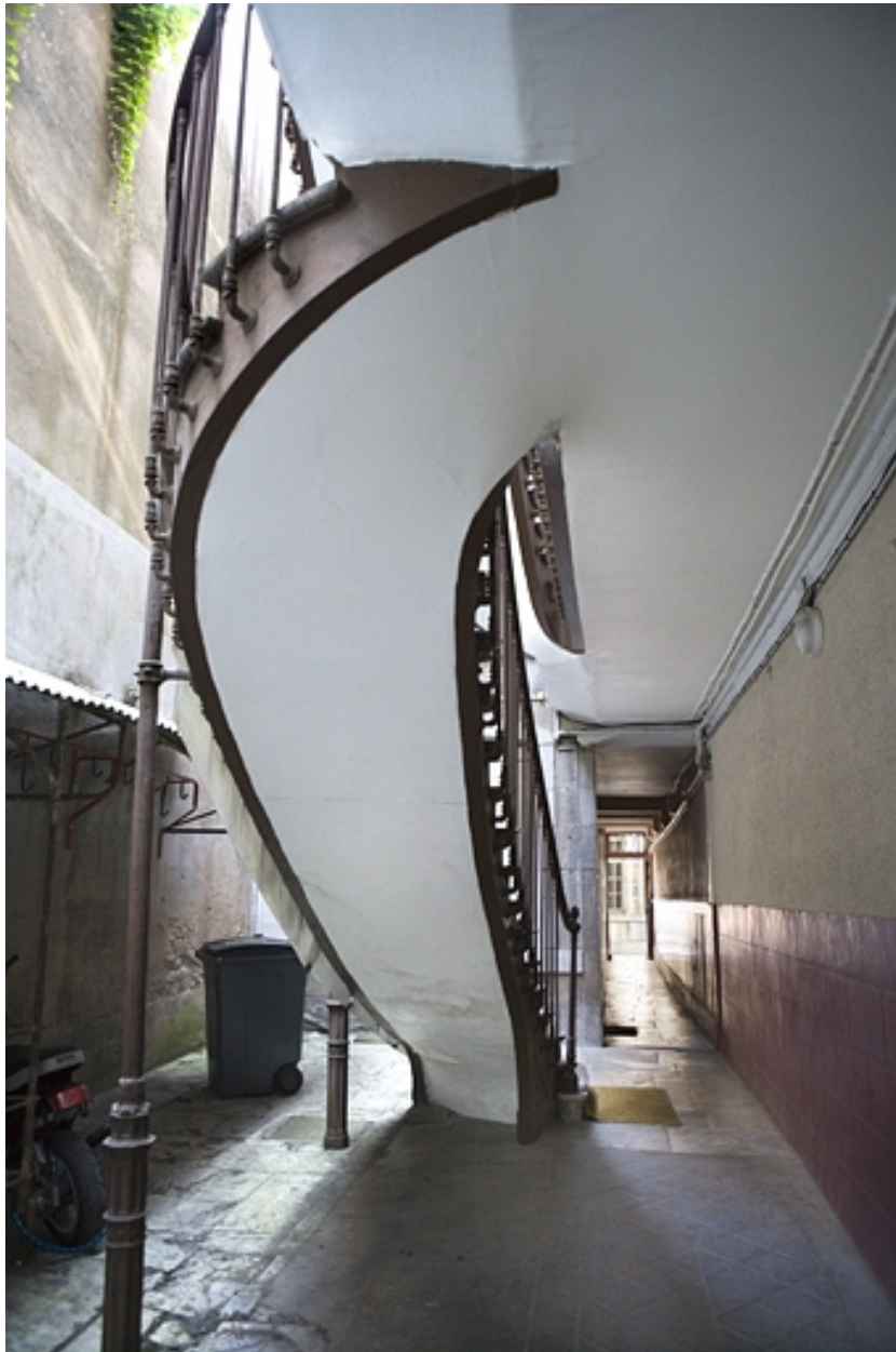
Détail de l'escalier à cage ouverte sur cour, depuis le fond de la première cour.
