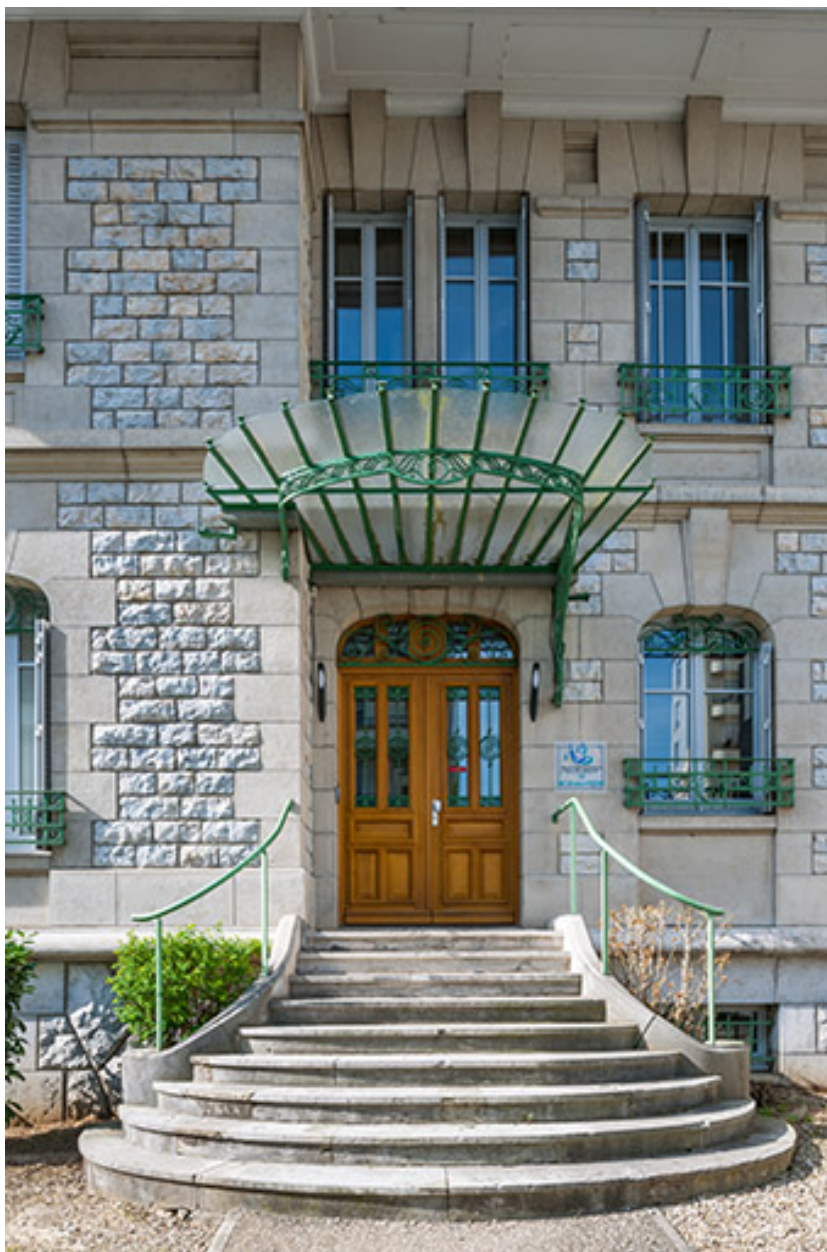
Façade antérieure : perron, entrée et marquise.
