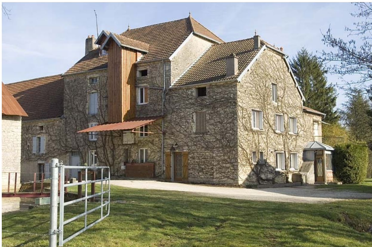
Vue rapprochée depuis l'ouest.
