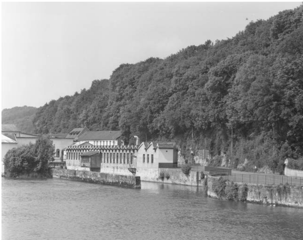
Vue d'ensemble depuis le pont. Vue rapprochée.
