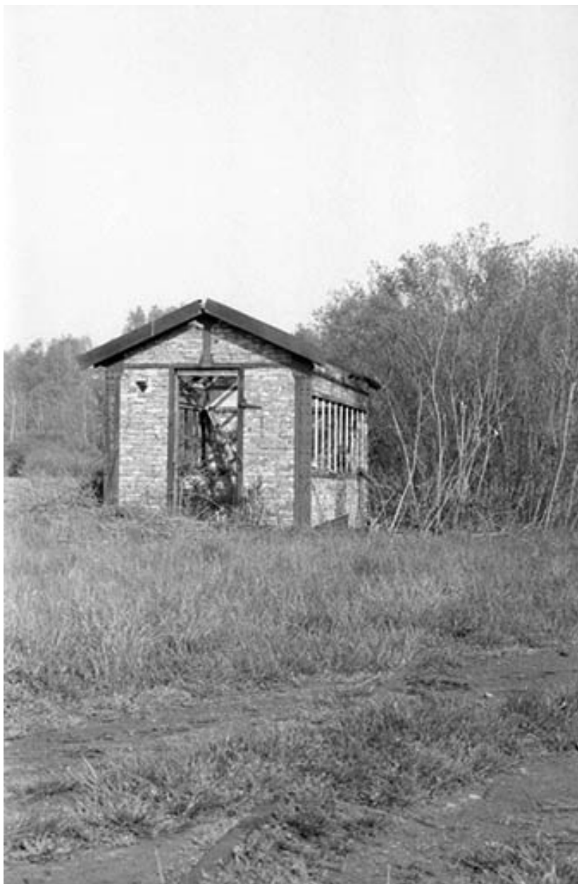
Forge Neuve. Bâtiment (Q) : pont-bascule ?
