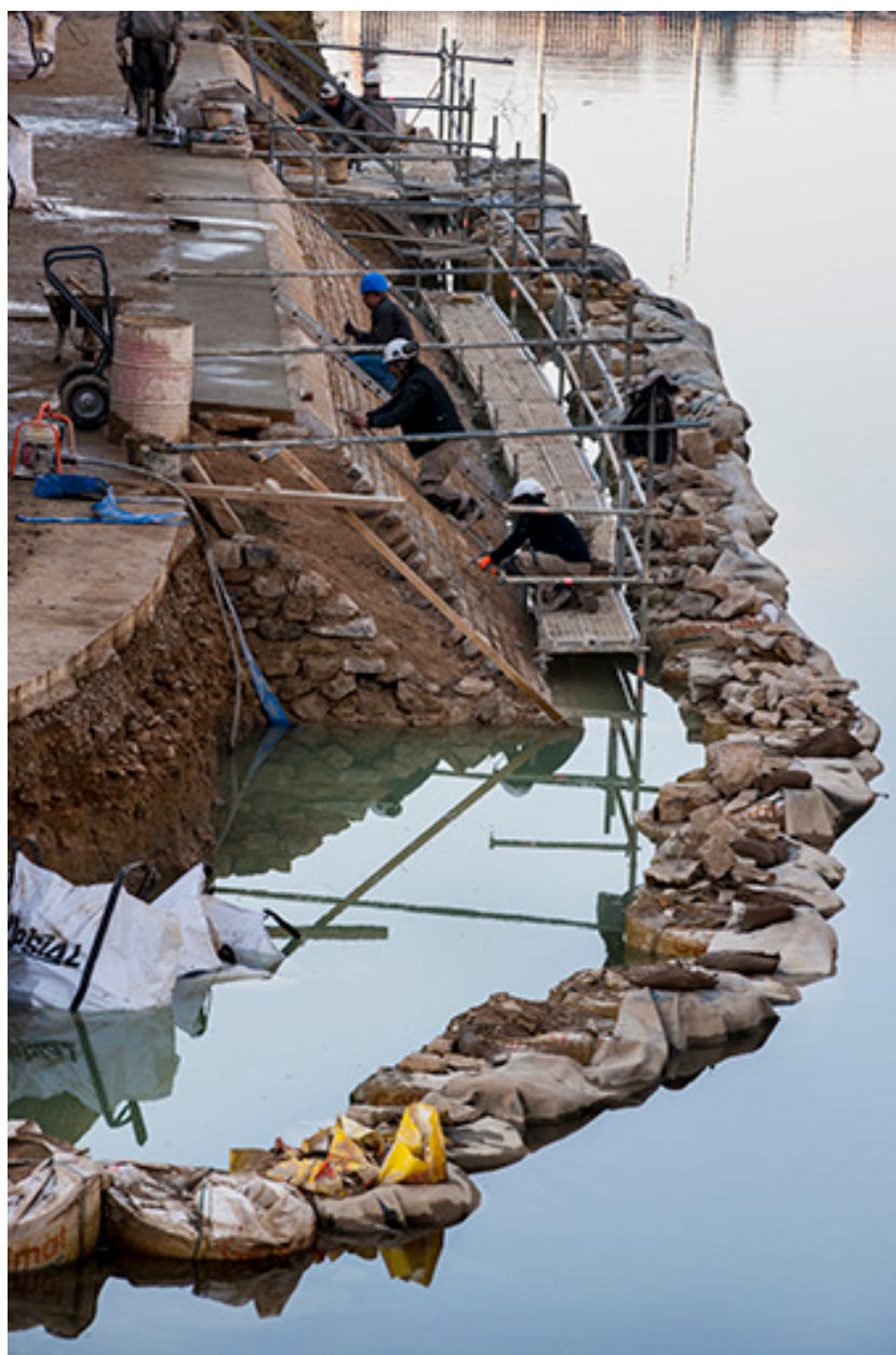
Réfection du perré du chemin de halage en aval du moulin Saint-Paul : coupe du perré.
