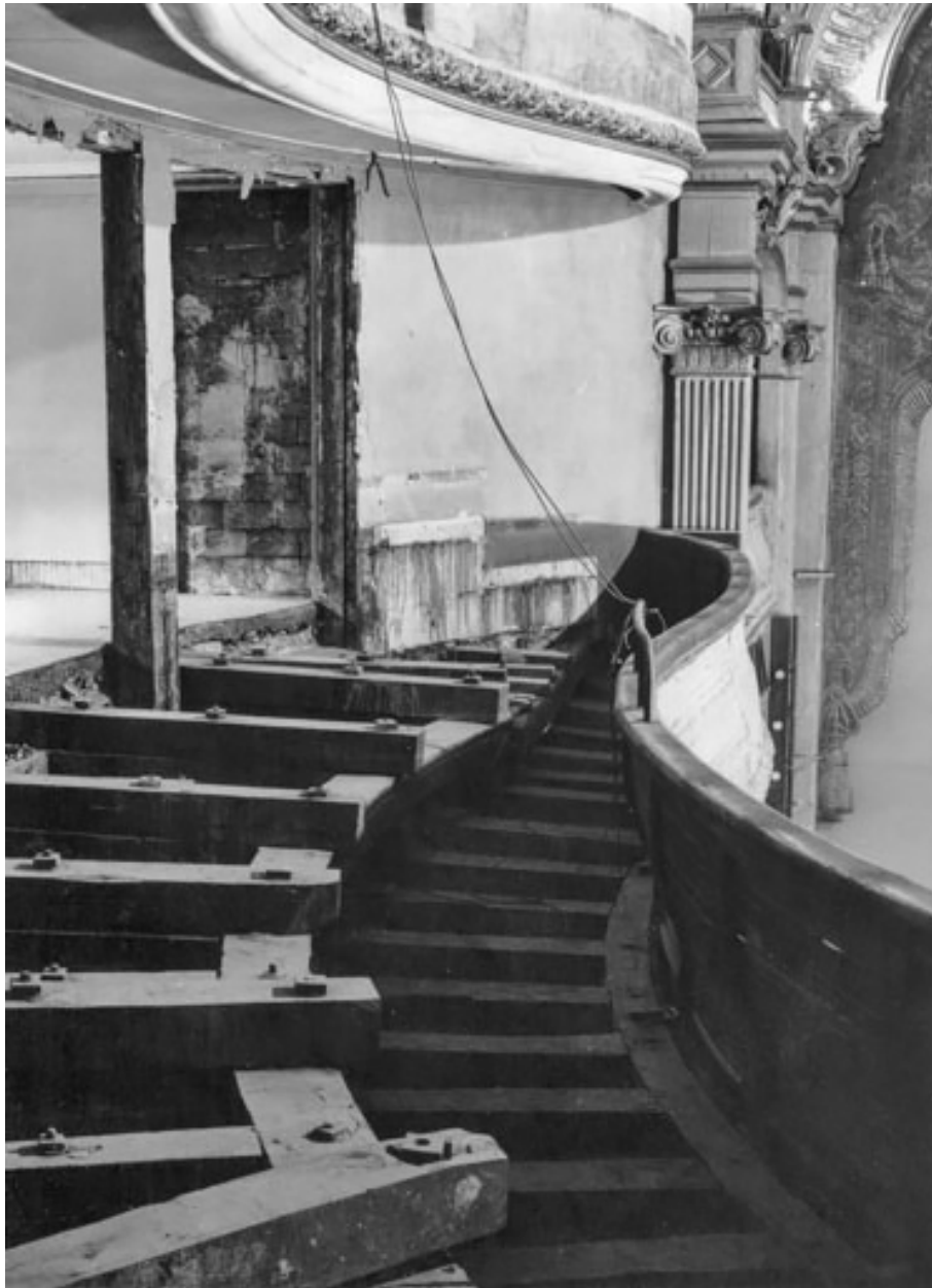
2ème galerie - ossature côté scène [pendant les travaux]. S.d. [1970].
