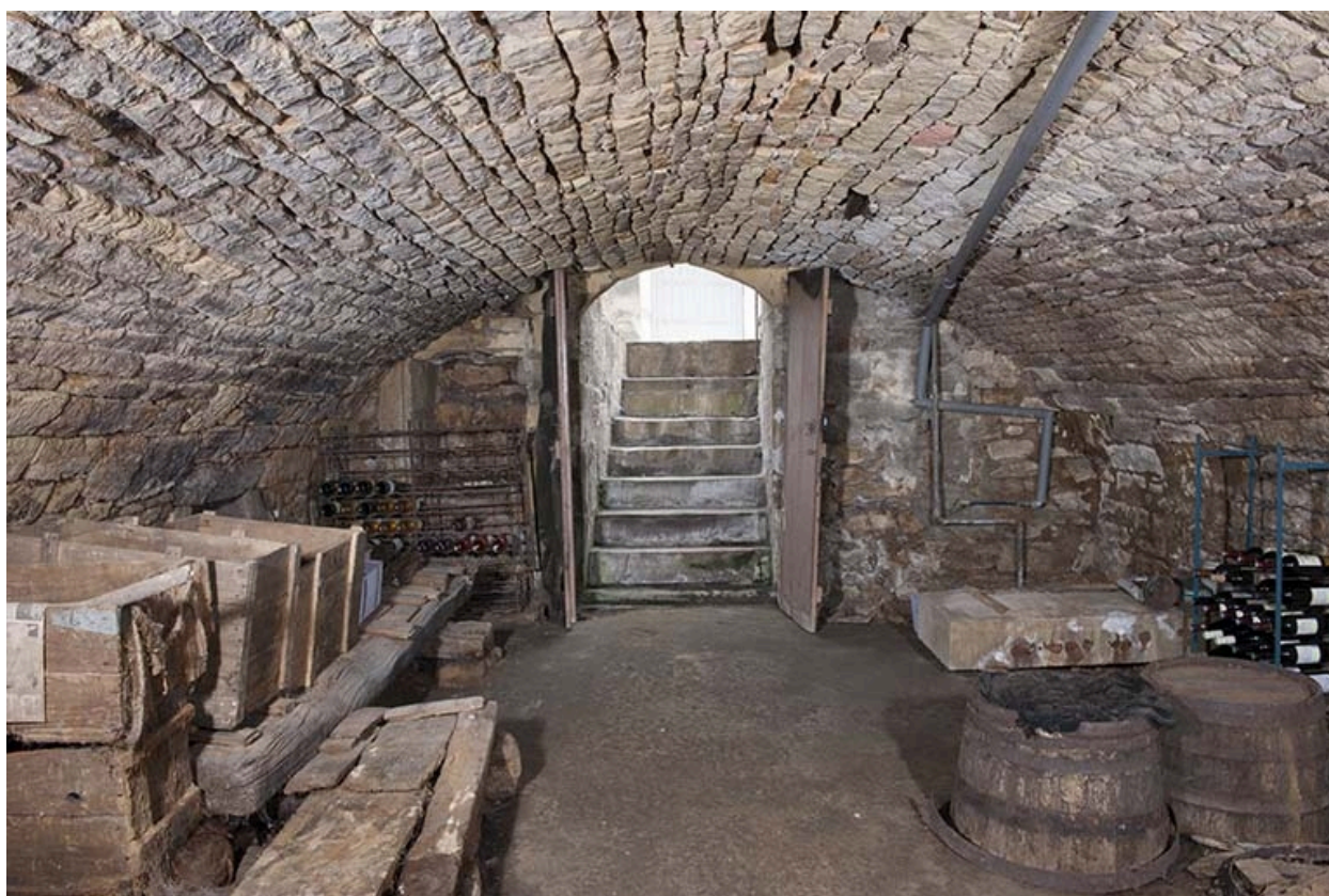
Sous-sol, en direction de l'entrée.
