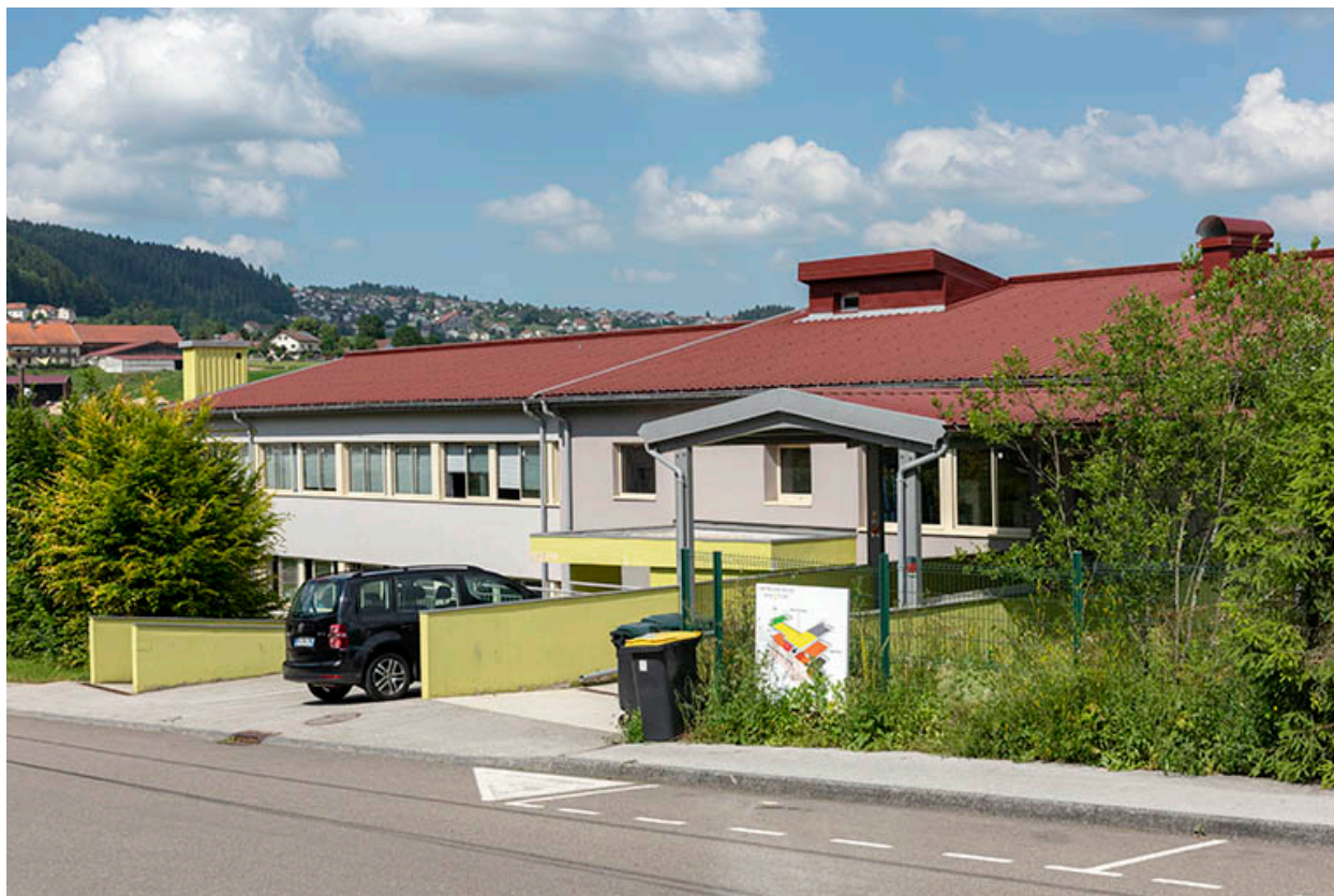
2e bâtiment, vu du sud-ouest.
