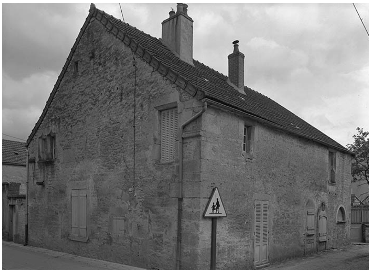
Mur-pignon et façade latérale.
