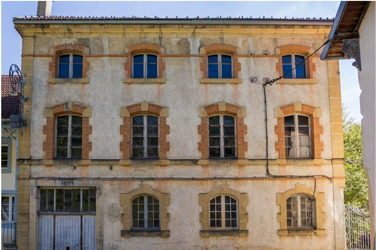
Deuxième atelier de fabrication : façade antérieure.
