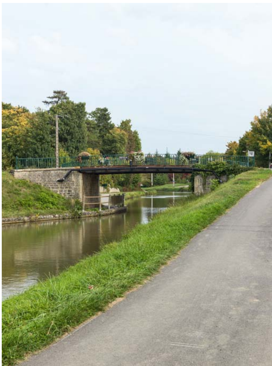
Vue d'ensemble du pont.
