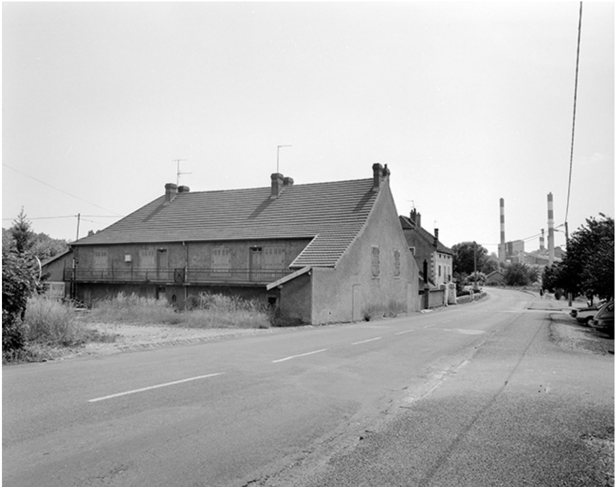
Logements d'ouvriers (7), vus de trois quarts droit.
