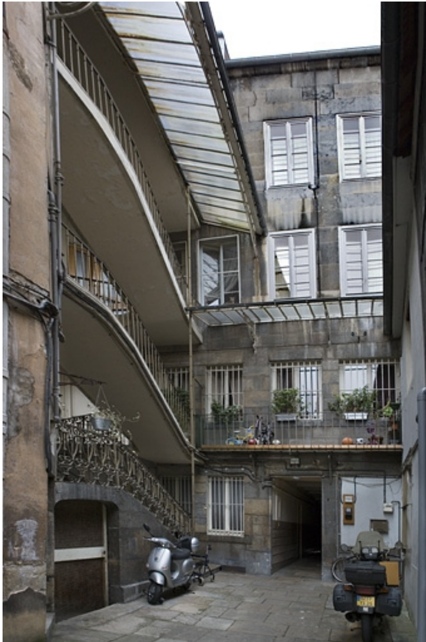
Vue d'ensemble de la façade postérieure du logis principal avec l'escalier à cage ouverte.
