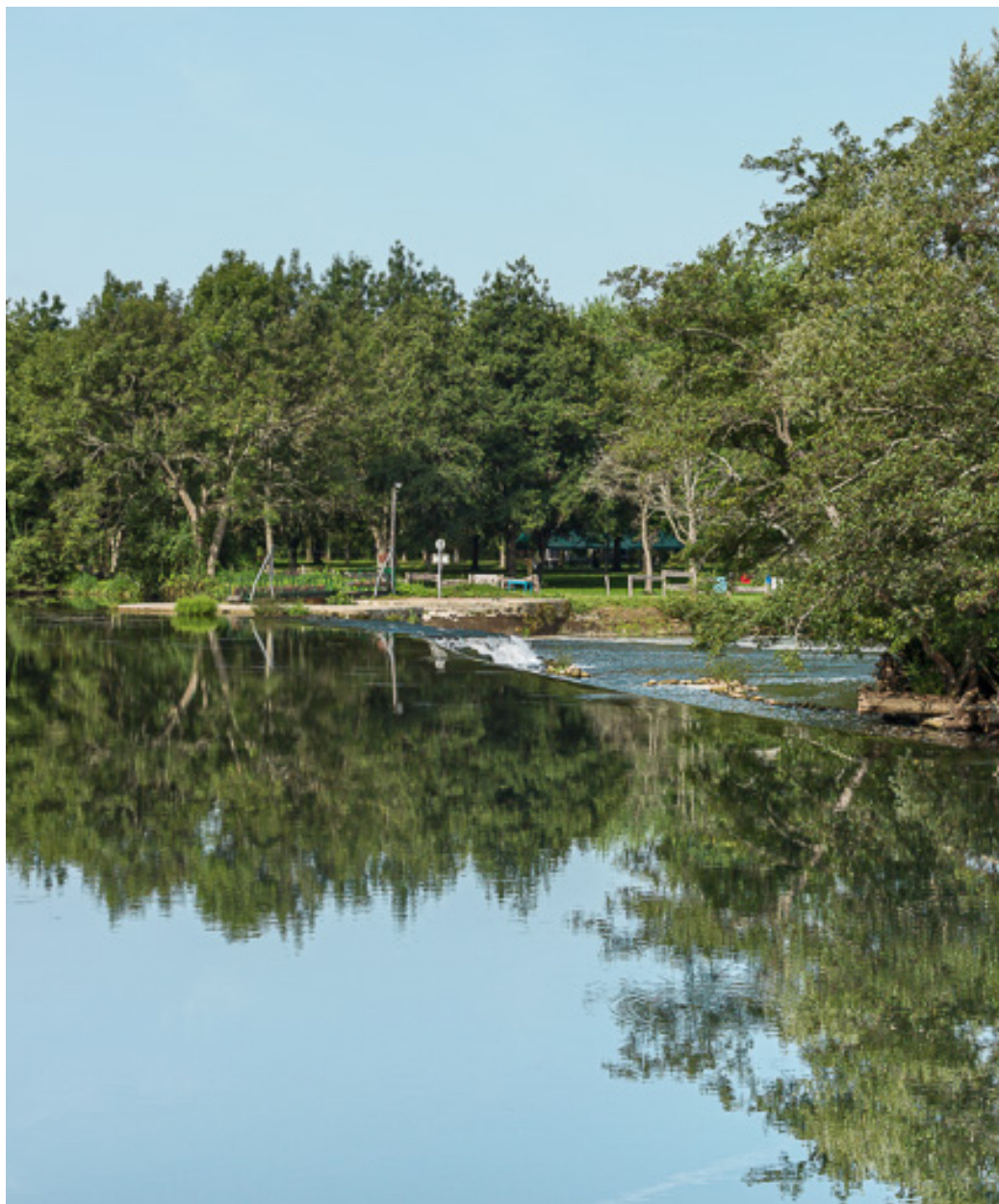
Vue du barrage à aiguilles.
