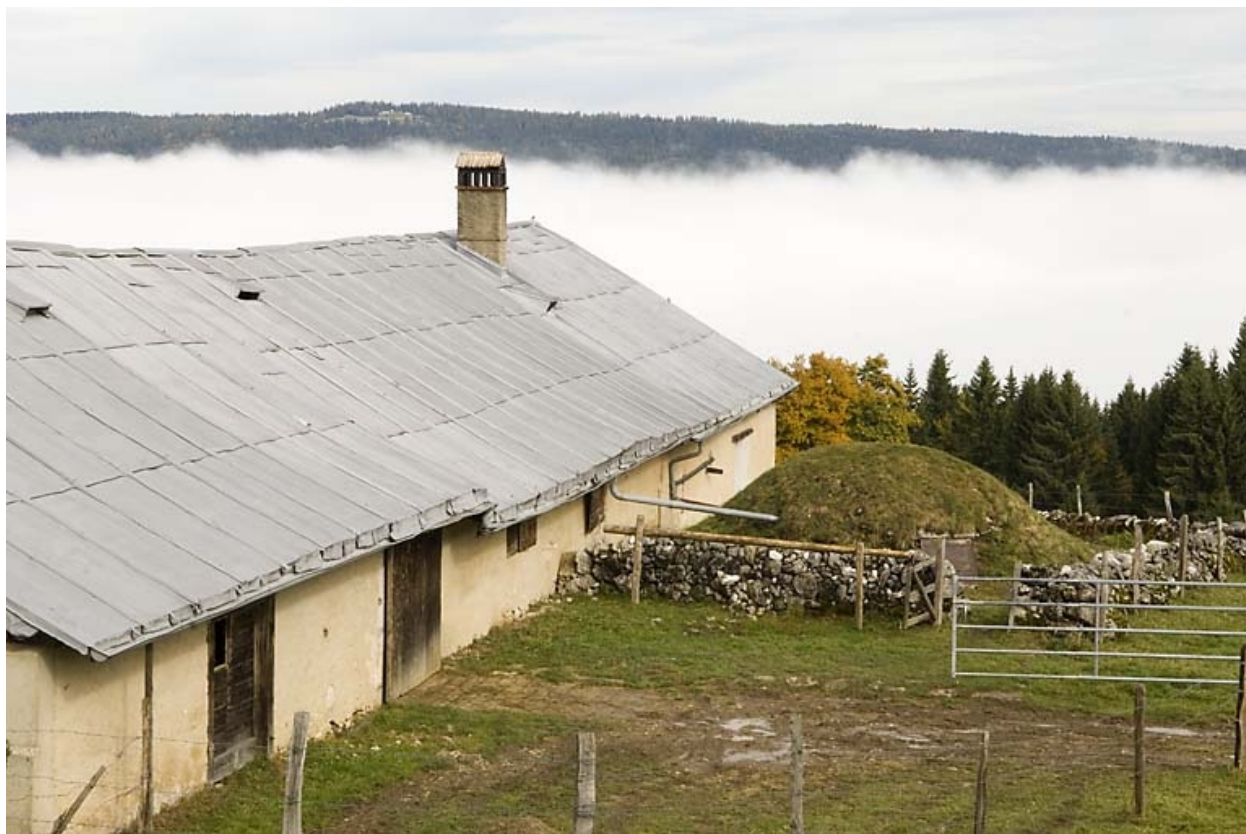
Façade antérieure vue en enfilade et citerne.
