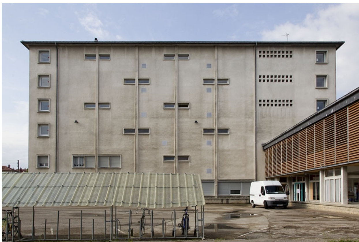
Internat garçons, vu du nord.
