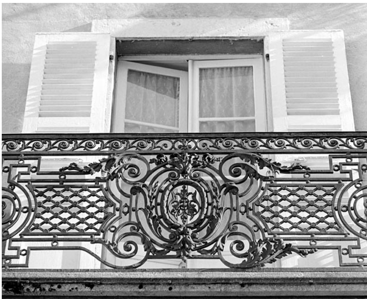
Balcon du premier étage : détail du garde-corps.
