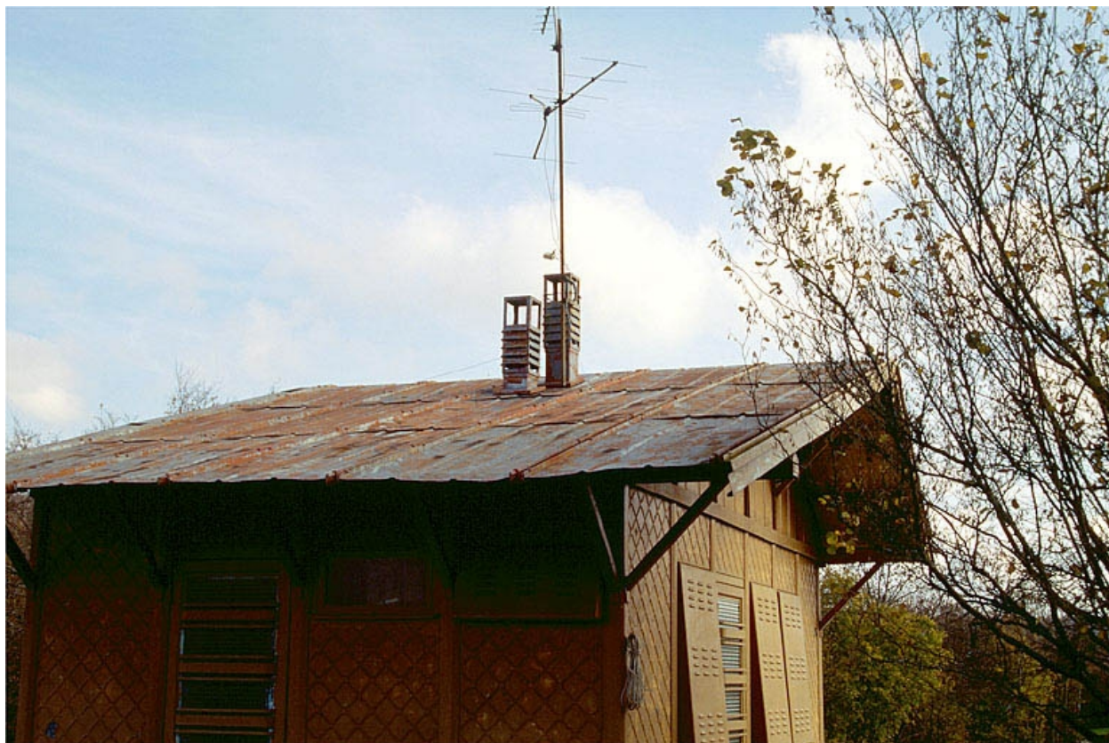
Toiture et cheminées.
