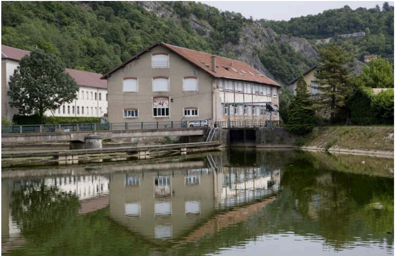
Façade latérale droite (amont) des ateliers de fabrication, de trois quarts droite.
