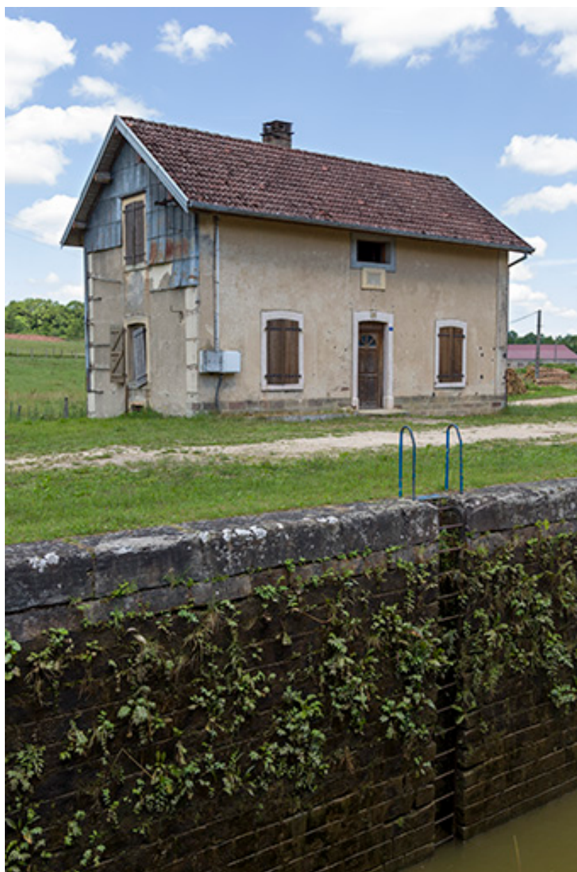
La maison d'éclusier, depuis l'écluse.
