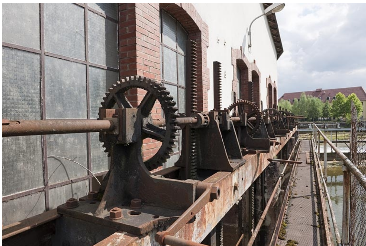
Détail du vannage de prise d'eau.
