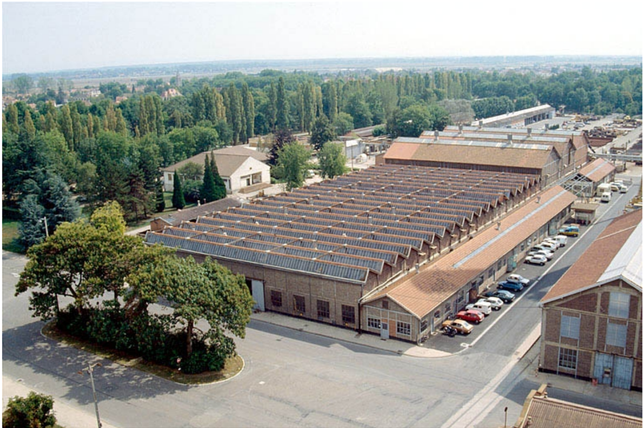
Ateliers de réparation vus depuis le haut de la soudière.
