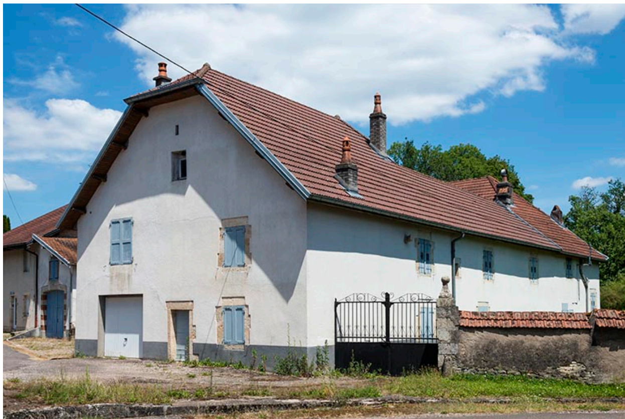
Vue sur la partie sud.
