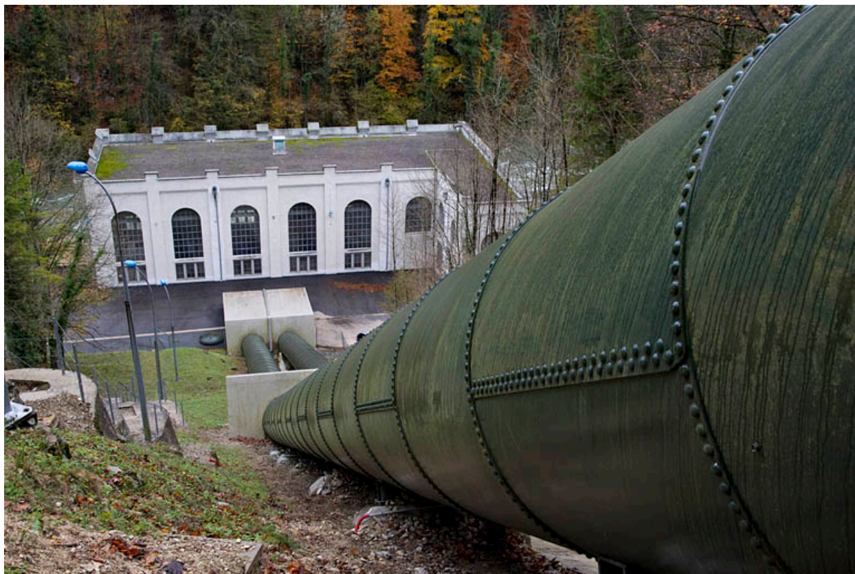
Conduite forcée : vue plongeante.
