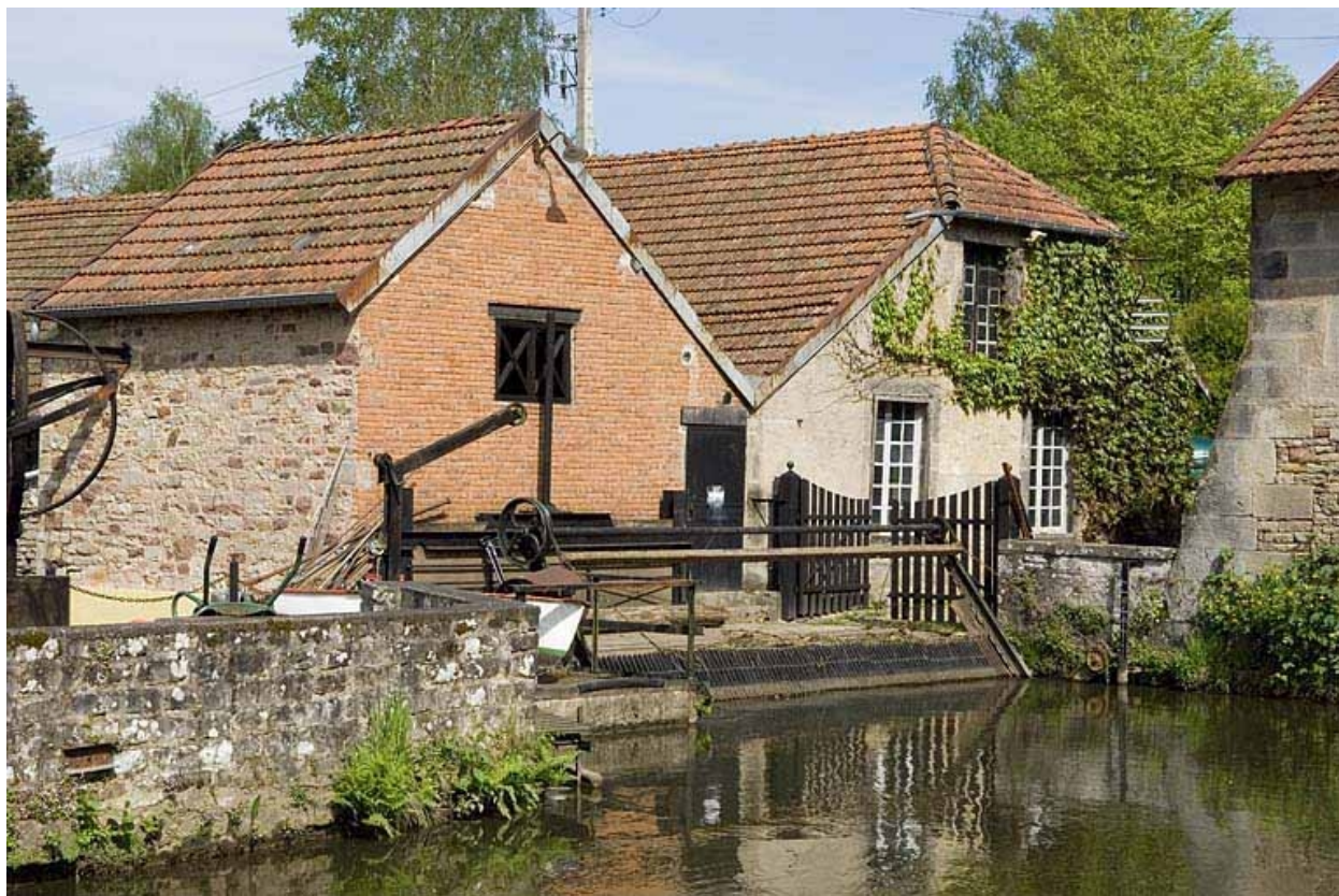
Salle des machines (nord).
